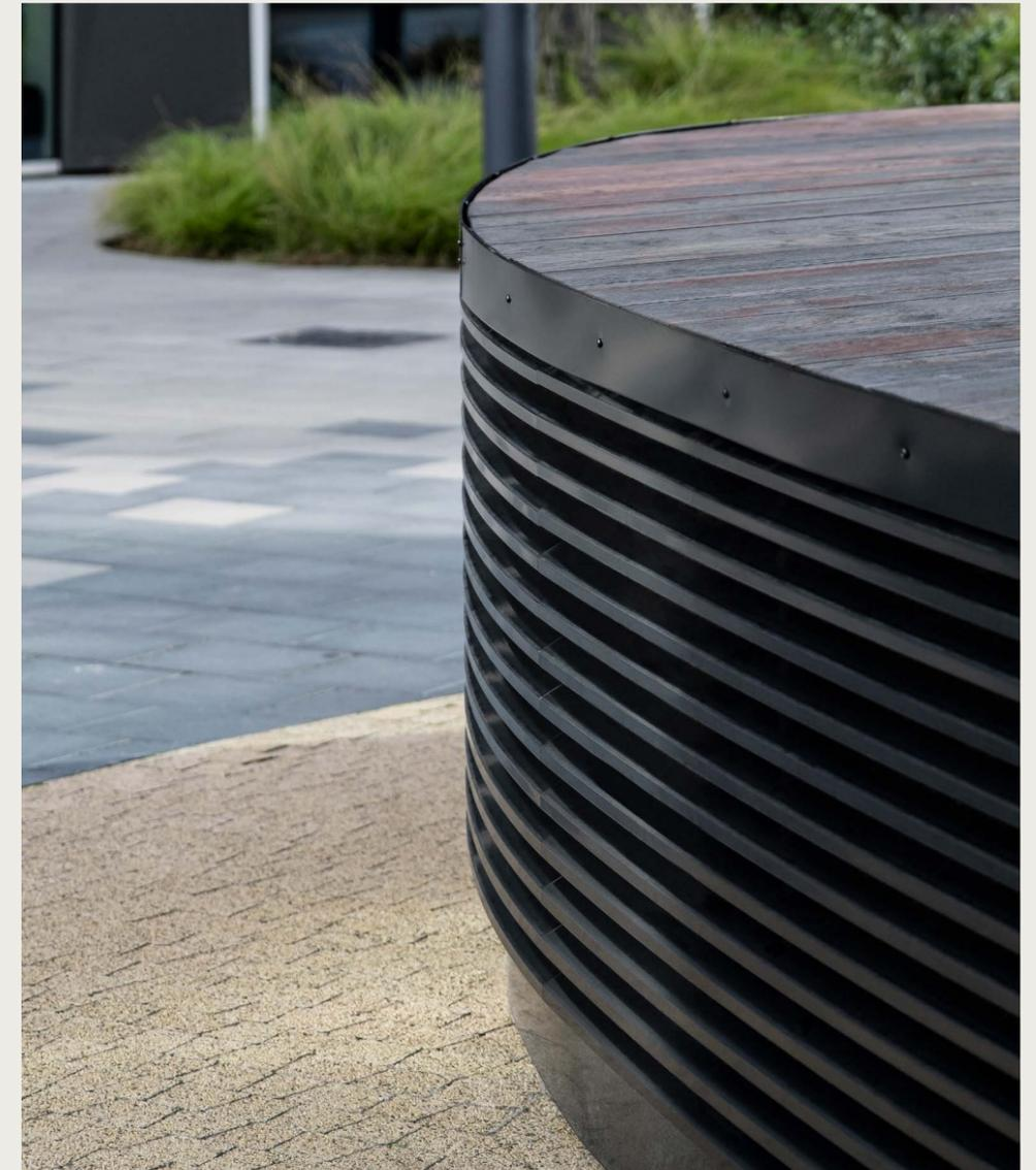
Les profils Linius permettent même de finir des façades ou des structures courbes d'un rayon minimum de 800 mm.
