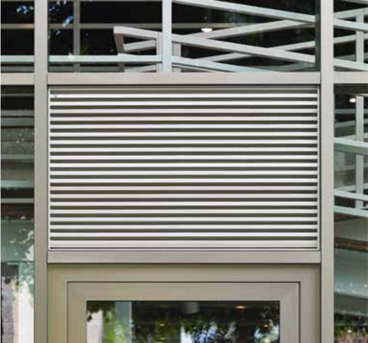
411 - Lüftungsgitter Einliegend
