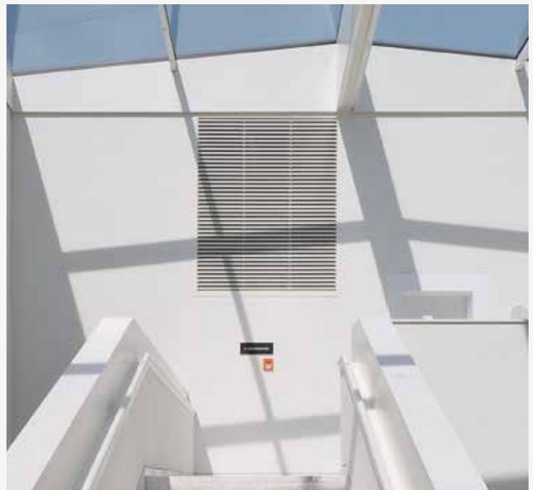
481 - Lüftungsgitter Einliegend schwere Ausführung
