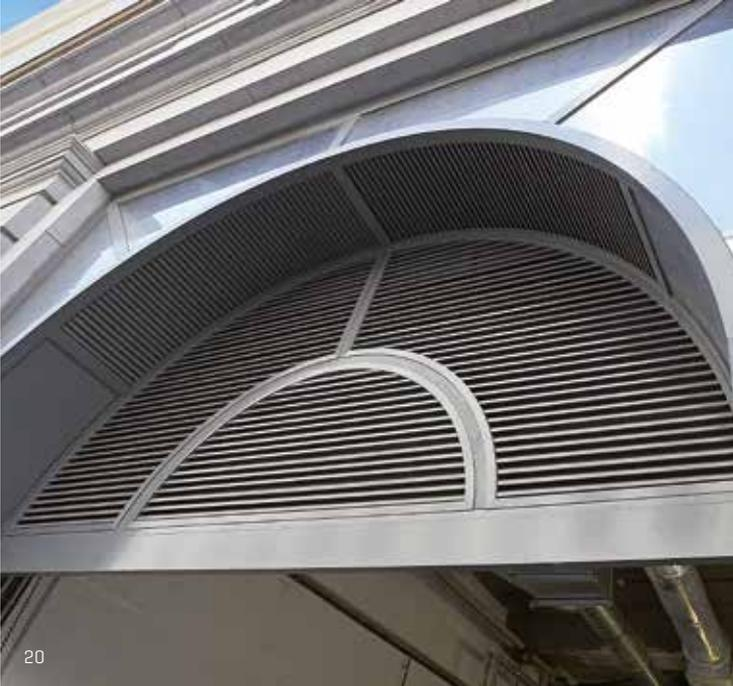
421 - Lüftungsgitter Einliegend schwere Ausführung
