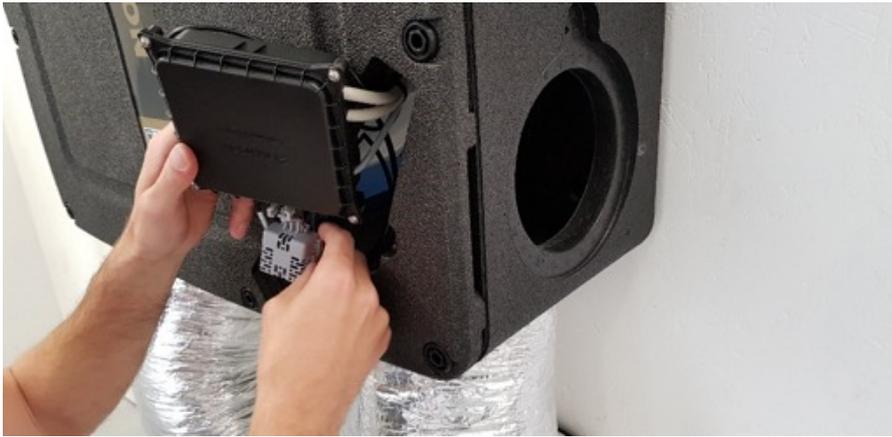
**Étape 5** • Si nécessaire, ouvrez le boîtier du capteur et nettoyez délicatement l'intérieur à l'aide d'un chiffon sec.
